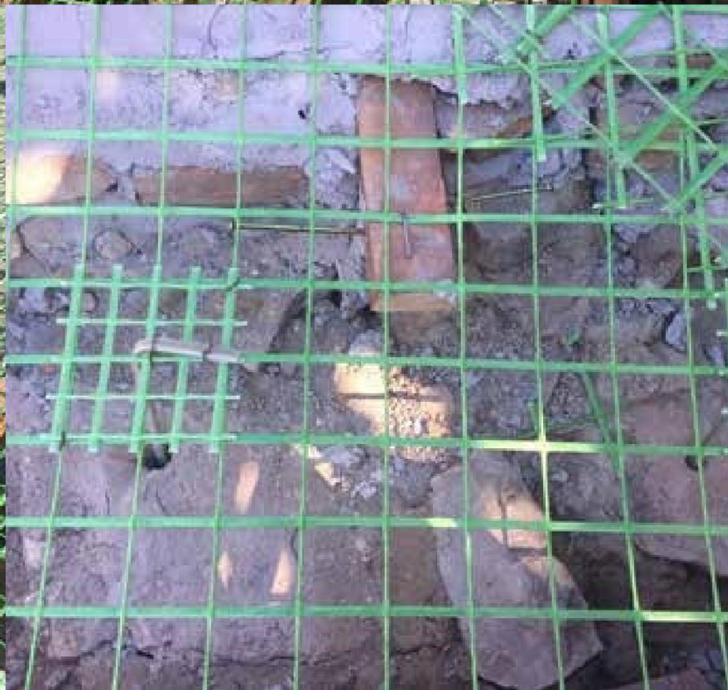
In un casolare ad Albano Laziale, in provincia di Roma, siamo intervenuti direttamente sul solaio, utilizzando una particolare fibra di vetro ideale per il rinforzo strutturale e l'adeguamento antisismico.
